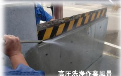
高圧洗浄作業風景
